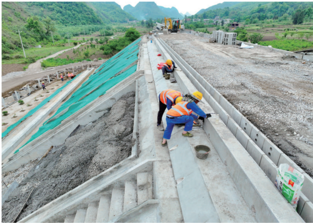
4月28日,中铁八局工作人员在进行路基施工作业。当前,位于贵州省镇宁县江龙镇境内的黄(桶)百(色)铁路贵州段站前二标段项目正在加紧建设。据了解,黄百铁路全长约315公里,设计时速160公里,为国家I级单线电气化铁路,预计2028年建成通车。项目建成后,将进一步完善西部陆海新通道布局,构建我国西部地区通江达海便捷大通道。新华社发 龙建睿 摄
