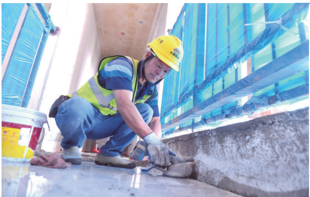
在南宁市鸡村城中村改造项目施工现场,中铁二十局的建设者在施工。
