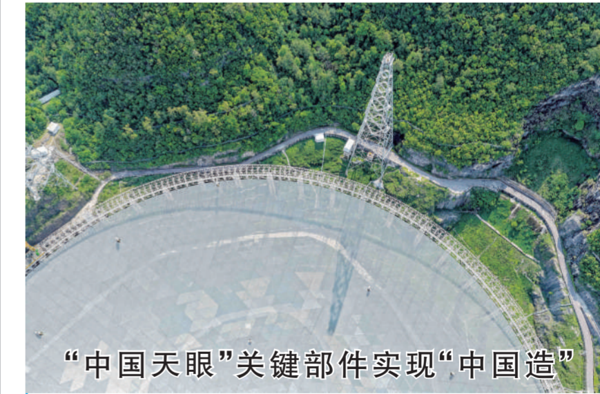
5月7日拍摄的“中国天眼”一景(无人机照片,维护保养期间拍摄)。
