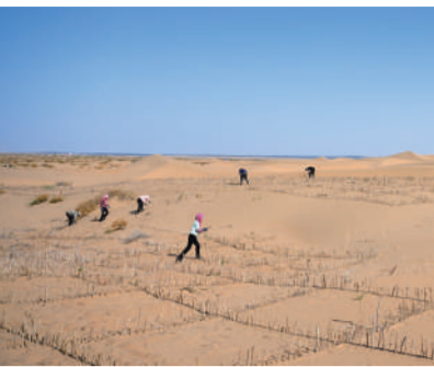
5月12日,治沙工人在内蒙古鄂尔多斯市杭锦旗境内的库布其沙漠栽植立式网格沙障。
