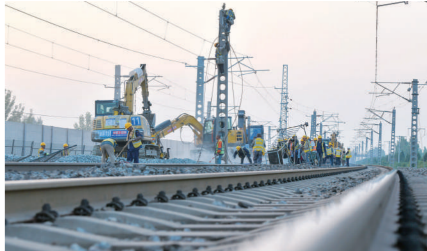
中铁十四局工程人员在京九铁路聊城北站上行线改建工程现场施工作业。5月11日,随着披挂施工圆满结束,由中铁十四局承建的京九铁路聊城北站上行线改建工程全线竣工。本次工程新建正线全长约7.6公里,设计时速160公里,涵盖特大桥、涵洞、轨道铺设及“四电”系统改造等多项内容。作为国家铁路网优化升级的重点项目,该工程的投用将打通区域铁路运输堵点,为京九干线提质增效、完善华北地区铁路网布局提供坚实保障。新华社记者 朱峥 摄
