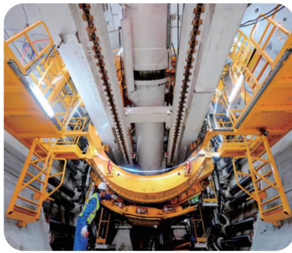
在龙烟铁路市域化改造工程烟台蓬莱国际机场隧道盾构段，工作人员对“龙烟市域号”盾构机进行始发前设备检查。
