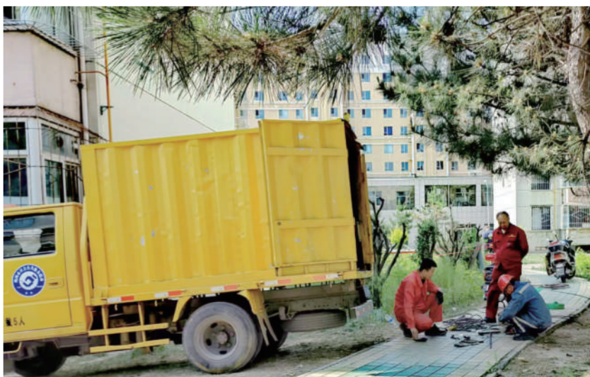
朔州市社会公共服务联动供热抢修车开进小区,开展供热设施“冬病夏治”专项排查,利用非供暖季窗口期,提前排查管网隐患、检修设备故障,为冬季稳定供热筑牢基础。 张建华 摄
