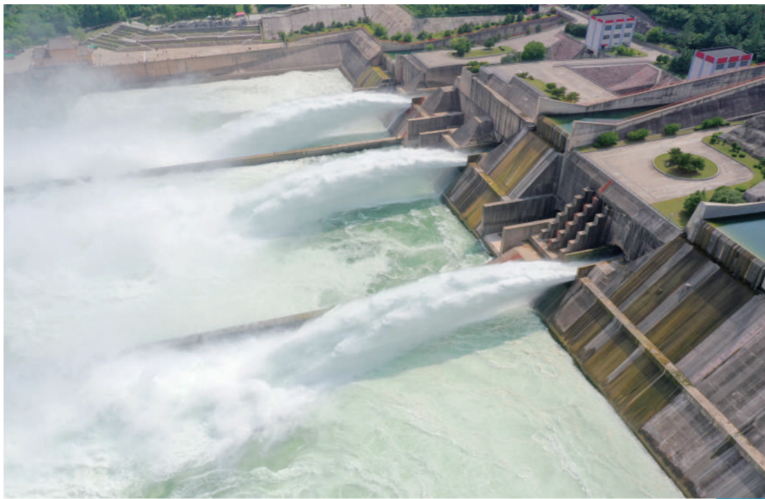
这是河南济源拍摄的小浪底水利枢纽工程调水调沙现场。
