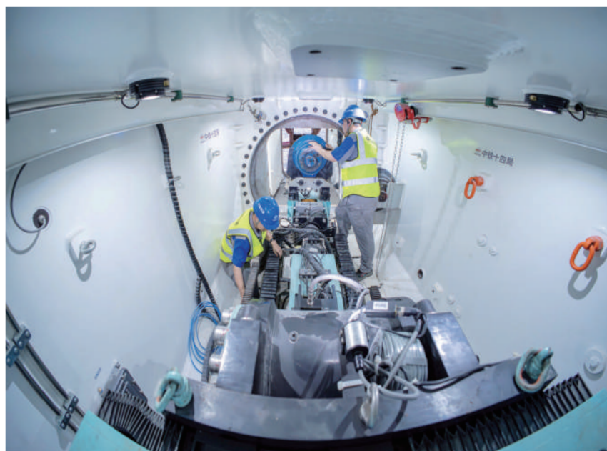
6月25日,在厦金大桥(厦门段)环岛路隧道“厦金号”盾构机掘进现场,工作人员在调试设备。 记者从中铁十四局集团获悉,6月25日,在厦金大桥(厦门段)环岛路隧道“厦金号”盾构机掘进现场,国产智能盾构换刀机器人正式投用。 据了解,机器人拥有11个独立可控活动关节,具备高避障能力与精细操作能力,凭借500公斤的负载能力和灵活伸缩的结构,可覆盖10米至18米级超大直径盾构机的整个刀盘,轻松抓取重型滚刀,精准完成更换。机器人整机软硬件实现100%国产化,拥有完全自主知识产权。 新华社发 范少文 摄
