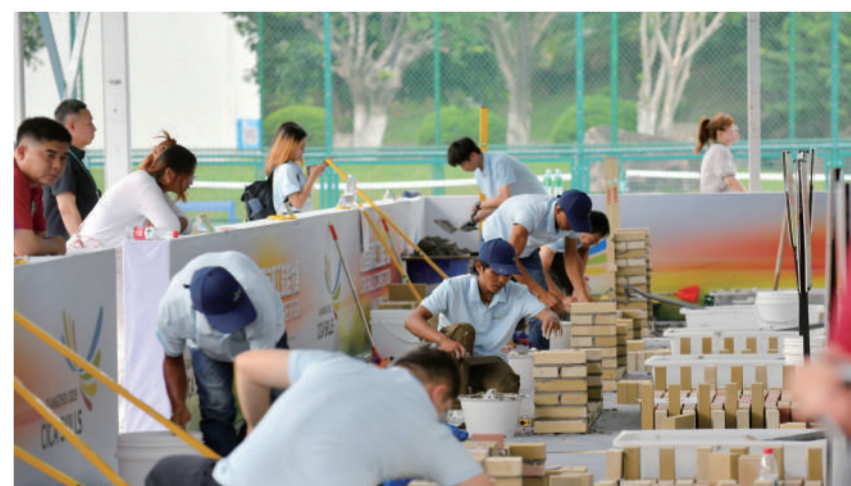
图为在亚信国家职工技能大赛现场，选手在砌筑项目竞赛中。7月1日，首届亚信国家职工技能大赛在广州开赛，设置砌筑、无人机械检修、高压电缆智能运检三个竞赛项目。本次赛事由中华全国总工会主办，是亚洲相互协作与信任措施会议(简称“亚信”)框架下首个国际性职工技能赛事，为亚洲各国搭建技能互鉴、人文互通、合作共赢的全新时代。
