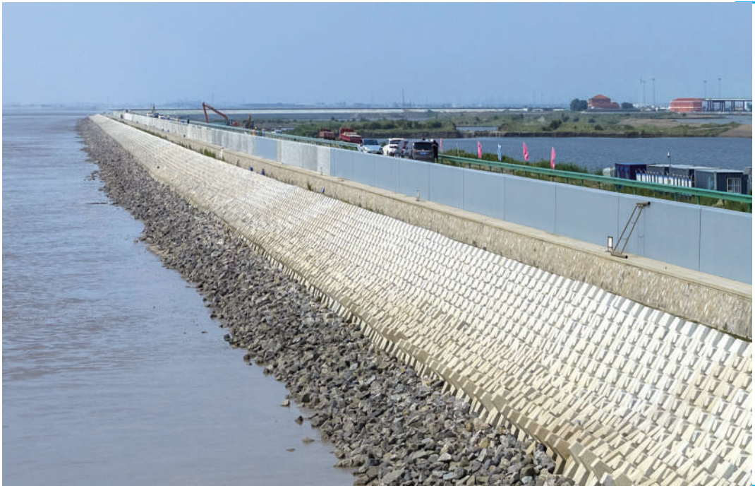
这是7月12日拍摄的天津市滨海新区防潮海堤一期工程。
