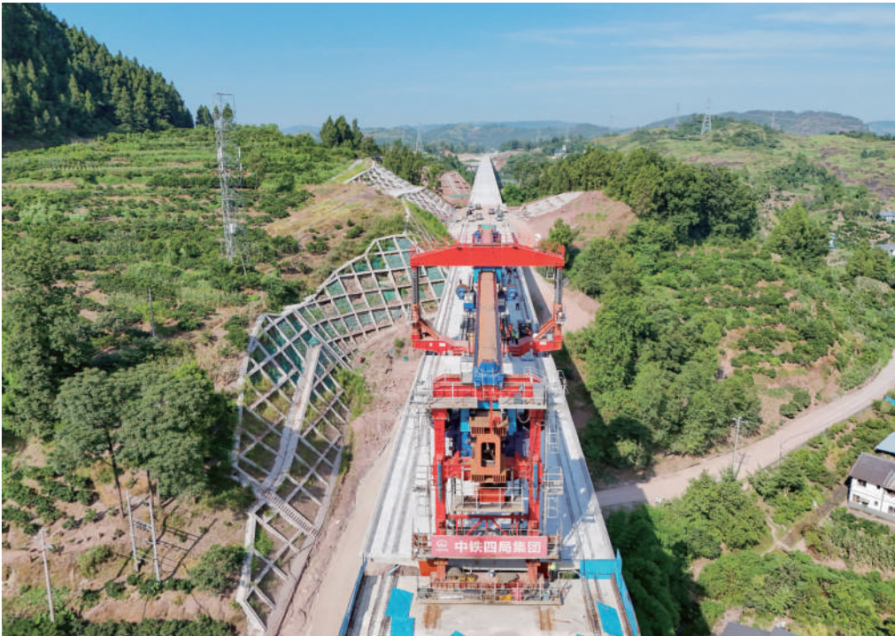
这是在四川省达州市拍摄的西渝高铁场坝村跨恩广高速公路大桥架梁施工作业现场。7月14日，最后一孔长32米、重约700吨的箱梁精准落位四川省达州市境内的西渝高铁场坝村跨恩广高速公路大桥桥墩，标志着西渝高铁全线箱梁架设任务顺利完成，为全线按期通车奠定坚实基础。
