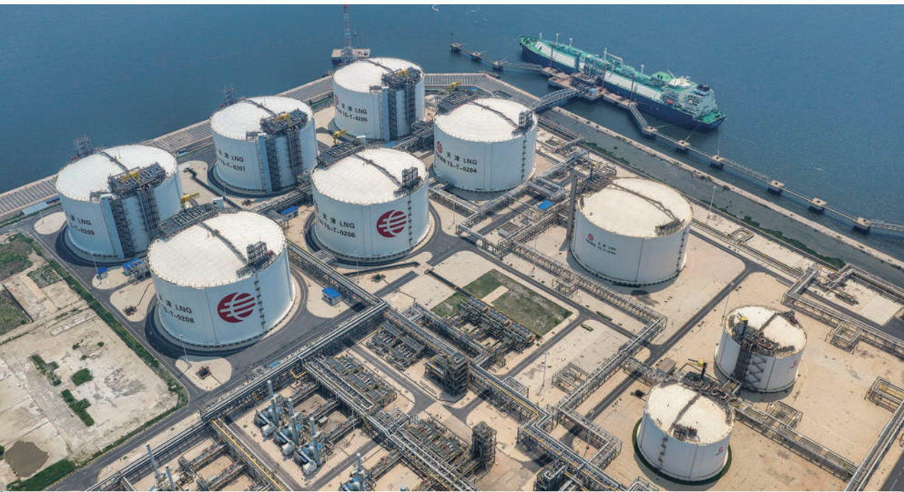
一艘来自海外的液化天然气运输船在国家管网天津LNG接收站码头靠泊（无人机照片）。7月19日，一艘来自海外的液化天然气(LNG)运输船顺利靠泊国家管网天津LNG接收站码头。这是国家管网天津LNG接收站自2013年投产运营以来接卸的第500艘LNG船舶。稳定到港的清洁能源进一步充实京津冀地区储气保供资源，为区域夏季用气高峰平稳度夏提供能源保障。 新华社发 杜鹏辉 摄
