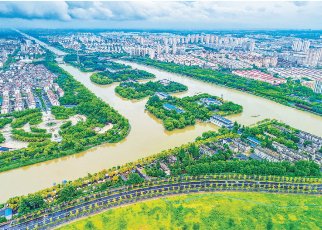
8月11日拍摄的位于江苏省扬州市江都区的南水北调东线源头江都水利枢纽。 据水利部和中国南水北调集团消息，截至8月10日，南水北调东中线一期工程调水超900亿立方米。其中中线一期工程调水超800.5亿立方米，东线一期工程调水超99.5亿立方米。 新华社发 任飞 摄
