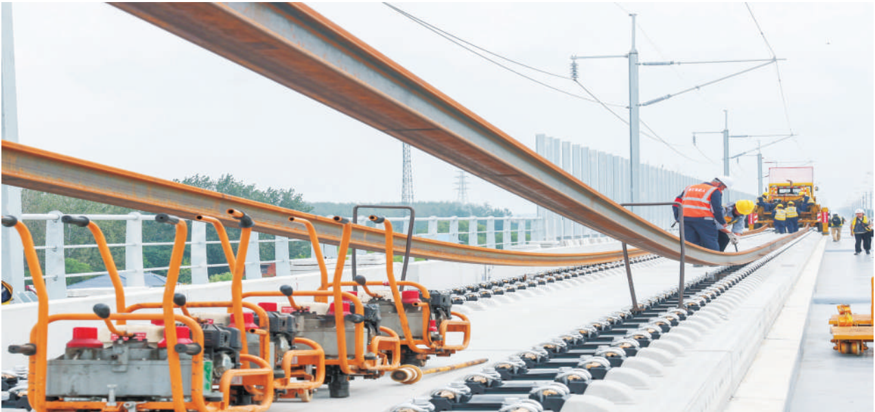
中铁四局施工人员在新建沪宁合高铁铺轨施工现场作业。9月1日,在位于安徽省合肥市肥东县石塘镇的新建沪宁合高铁铺轨施工现场,施工人员进行对500米长钢轨铺设在无砟轨道上,这标志着新建沪宁合高铁全线启动铺轨。据悉,新建上海至南京至合肥高速铁路是国家中长期铁路网规划“八纵八横”中沿江通道的重要组成部分,是江北沿江城市与南京都市圈、上海都市圈快速直达的快捷通道。
