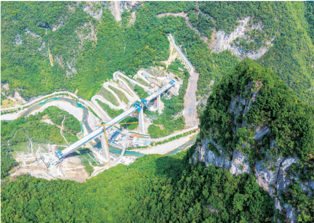
这是拍摄的西渝高铁朱家山隧道建设现场。9月8日,由中铁一局承建的西渝高铁朱家山隧道顺利贯通,为全线按期建成通车奠定坚实基础。 目前,西渝高铁康渝段已贯通隧道65座,工程整体全面进入无砟轨道施工、站房建设及四电工程安装的关键攻坚阶段。西渝高铁建成通车后,将与已运营的成渝高铁、郑渝高铁及在建的渝昆高铁等多条干线铁路互联互通,进一步完善中西部地区高速铁路路网结构。 新华社记者 唐奕 摄
