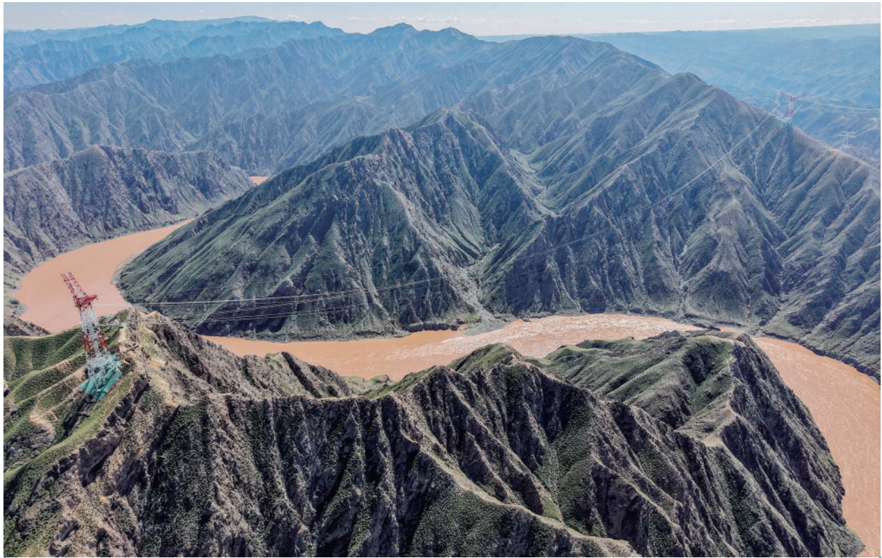
这是在甘肃省白银市景泰县和靖远县交界处拍摄的已经贯通的陇电入浙工程黄河大跨越段。9月14日，在甘肃省白银市景泰县与靖远县交界处，随着最后一根900毫米特强钢芯高强铝合金导线展放就位，甘肃至浙江±800千伏特高压直流输电工程(简称陇电入浙工程)顺利完成黄河大跨越架线施工，标志着陇电入浙工程甘肃段实现全线贯通。黄河大跨越段是陇电入浙工程全线唯一跨越黄河区段，也是整个工程的控制性节点，跨越段线路全长2.731千米，导线最低点距离黄河水面240多米。据介绍，陇电入浙工程是国家电力发展规划重点项目，工程线路西起甘肃武威换流站，东至浙江绍兴换流站，全长2370千米，途经甘肃、宁夏、陕西、河南、安徽、浙江六省区，预计2027年建成投运，届时每年可向浙江输送电量超过360亿千瓦时，其中新能源电量超过212亿千瓦时，将有力支撑东西部地区能源协同发展和绿色低碳转型。
