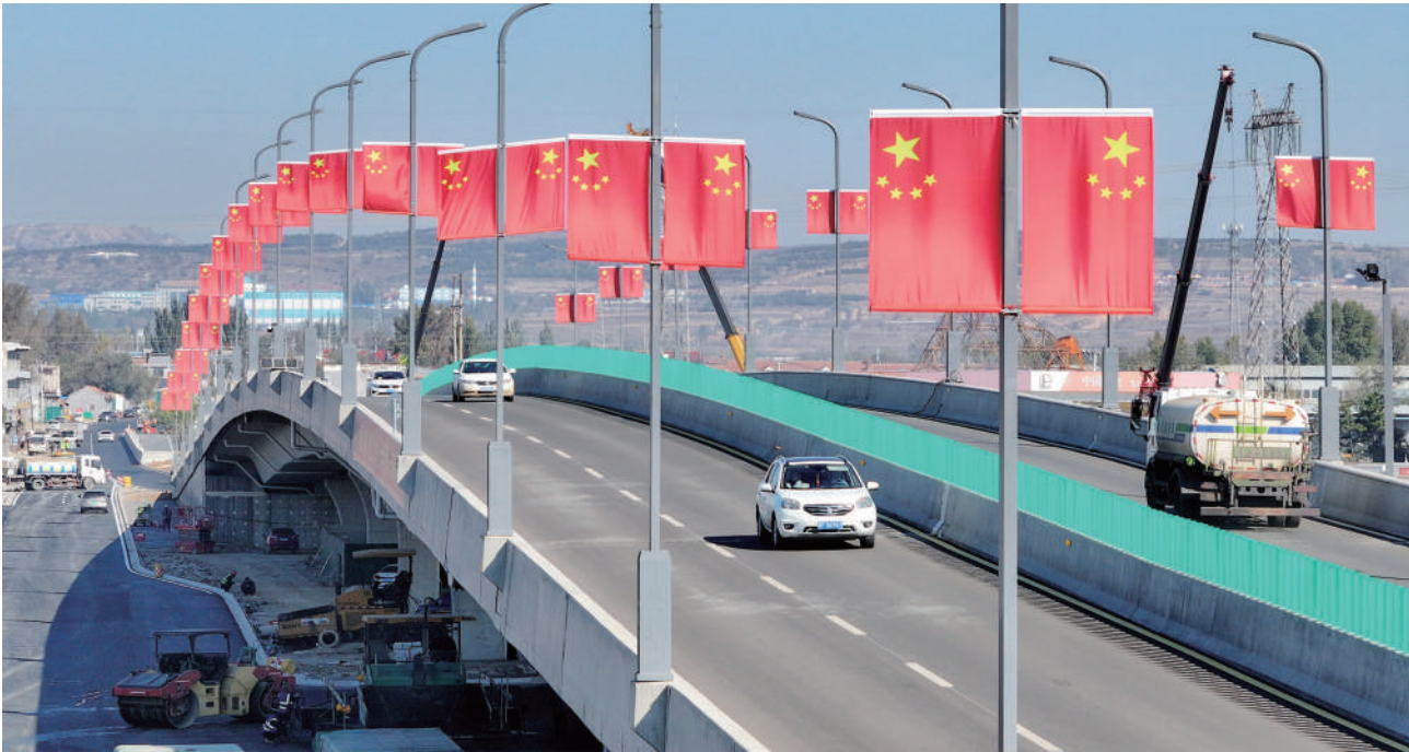
10月8日，车辆依次通过长422m、宽18.5m的朔州市区西北出口道路南北向跨线桥，标志着该道路改造工程正式通车。 齐慧强 摄
