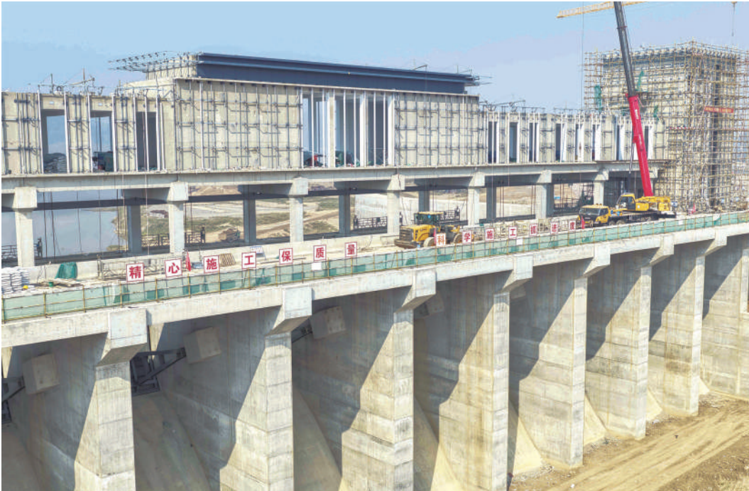
10月11日拍摄的蒙河双墩水库项目施工现场。眼下，位于山东省临沂市沂南县的蒙河双墩水库工程项目建设进展顺利。据悉，山东蒙河双墩水库工程是淮河流域综合规划的重大水利工程，于2022年11月正式开工，预计于2026年11月完工。工程建成后，将有效缓解沂河干流及临沂市区防洪压力。 新华社发 王彦冰 摄
